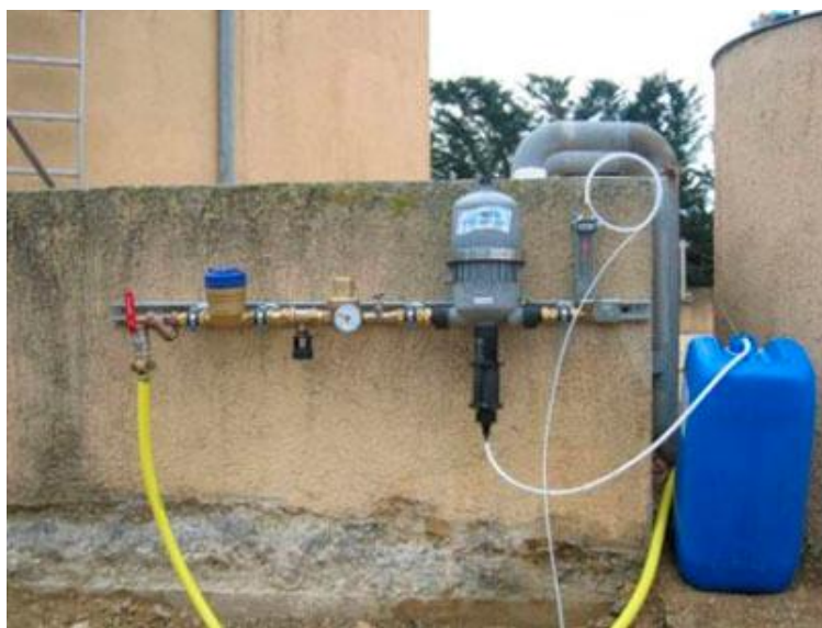
Рис. 2. Дозировочная насосная система с обязательным предварительным разбавлением
